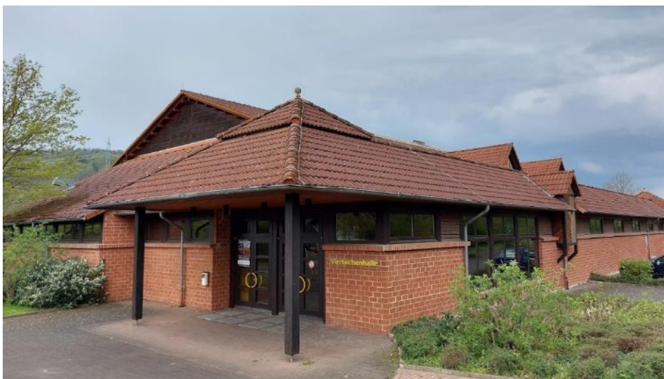
Abb. 20: Vierbuchenhalle in Röhrenfurth
