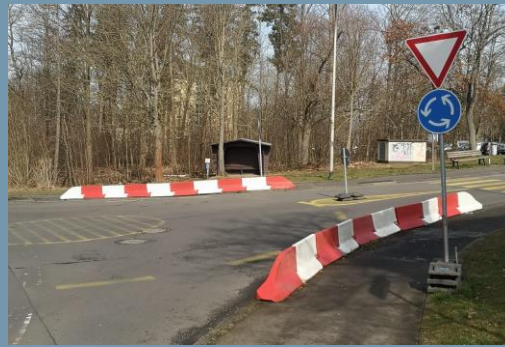
Provisorischer Kreislauf, Waldschwimmbad
