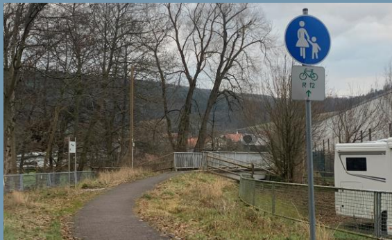
Brücke über die Pfiemme, Adelshausen
