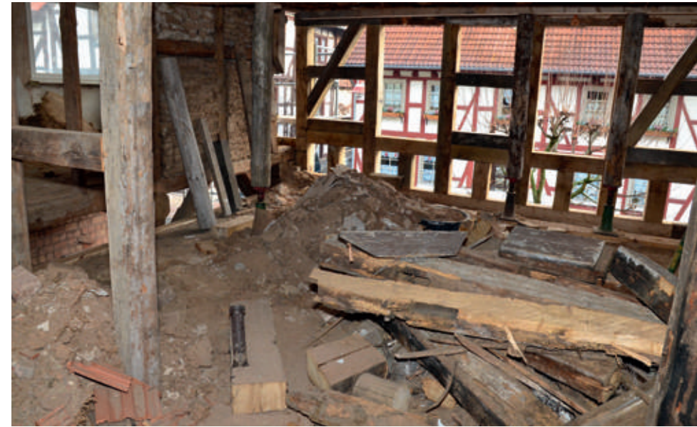
Das Haus der Pagels zu Beginn der Sanierung.
