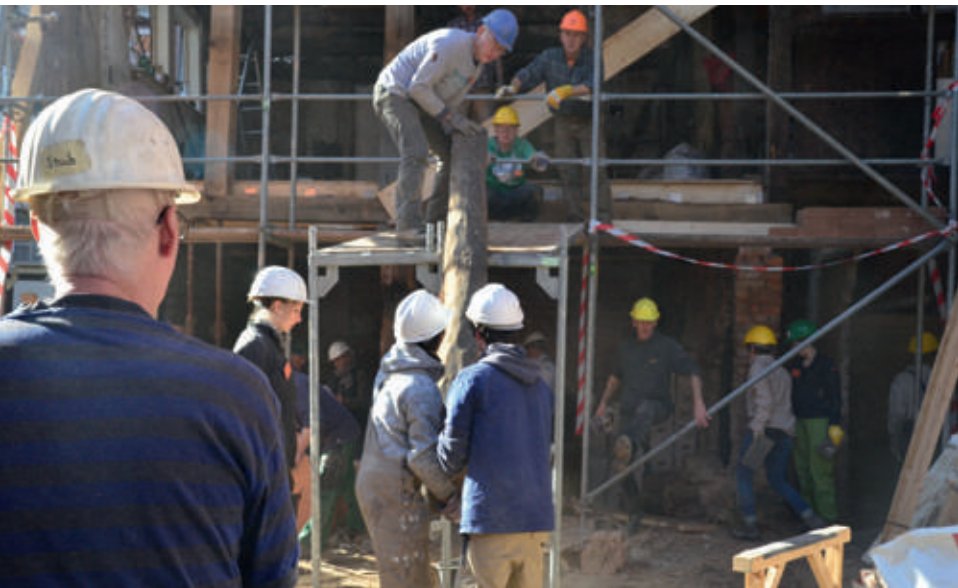
Freiwillige helfen bei der Sanierung des Genossenschaftshauses in der Mündener Speckstraße.
